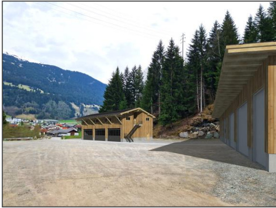
Vista luvratori nov / Ansicht Neubau
